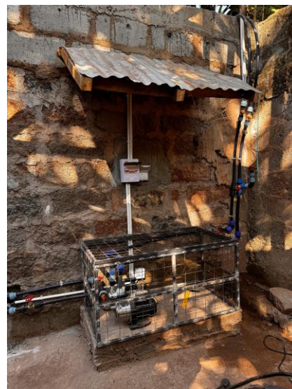
Abb. 10: Neue Hauptpumpen
