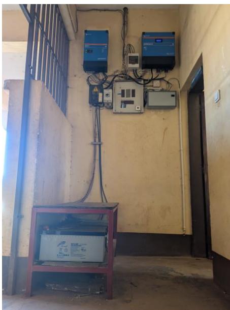
Abb. 15: Neuer Batteriespeicher mit Solarkomponenten
