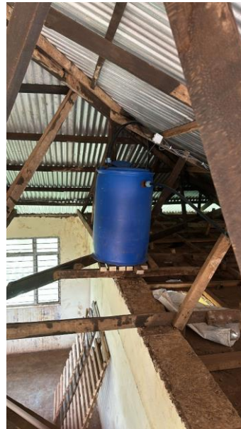
Abb. 8: Puffertank im Waschraum
